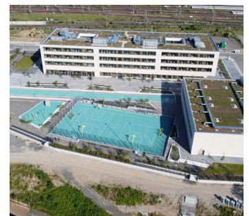
Gymnasium Hauptbahnhof-Westseite, Leipzig Foto: OTTO WULFF Bauunternehmung GmbH © Gunter Binsack
